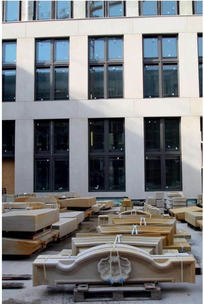
Montage der Architekturbeton-Fertigteile
